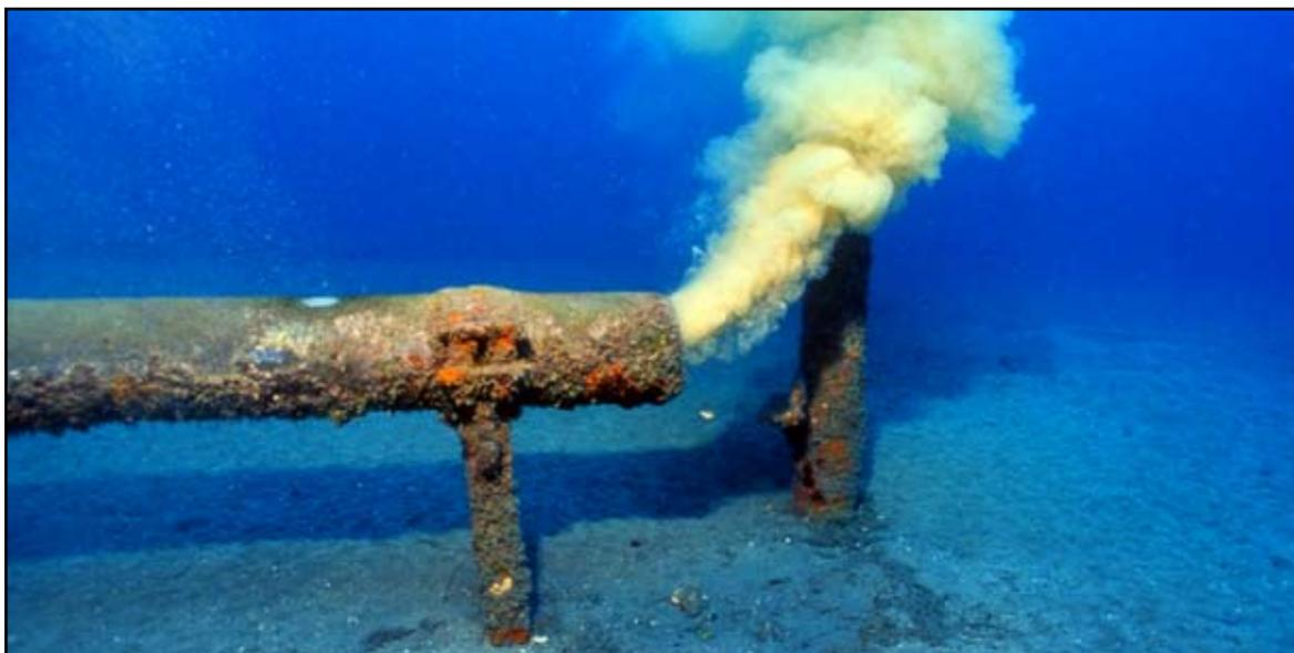
**Foto 16.** Vertido de aguas residuales urbanas a través de un emisario submarino.
