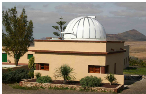
Vista de la Cúpula del Observatorio de Tefía
